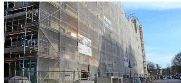
Zurzeit stellt sich das erste der beiden Mehrfamilienhäuser an der Theodor-Heuss-StraÙe in Peine noch so dar. HARALD MEYER/FMN
